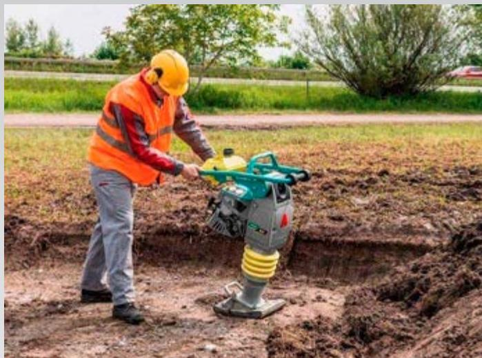
Figura 4 – Compactador a percussão com motor a combustão em aplicação clássica.
